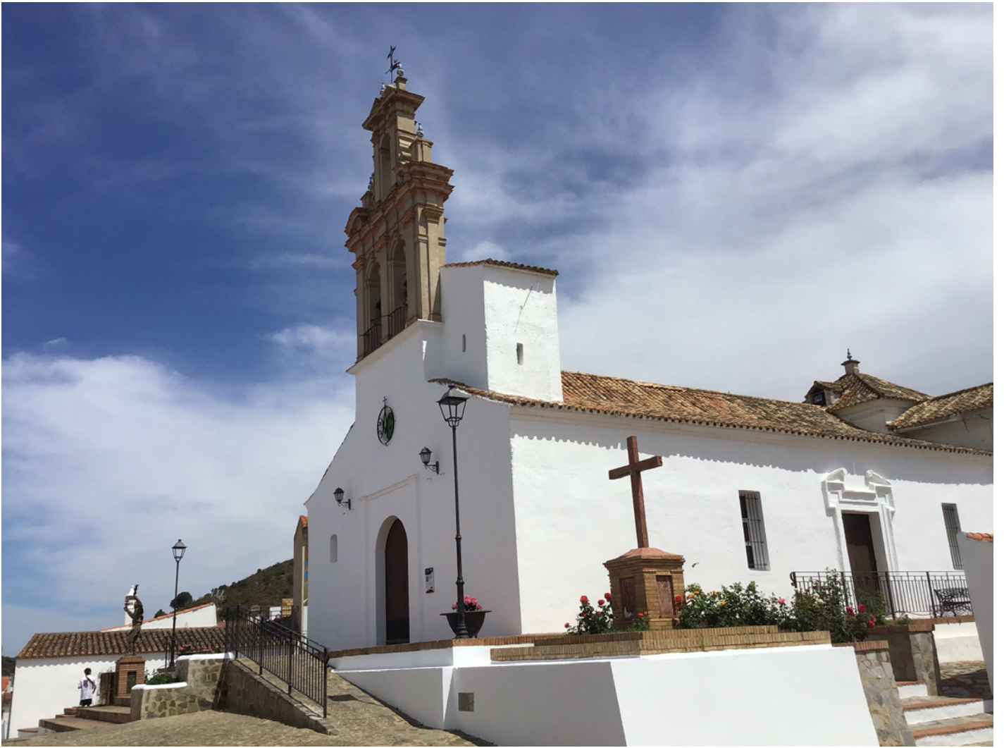
Huelva // Sanlúcar de Guadiana, Plaza Iglesia
